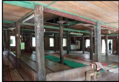
Gambar 8. Tiang utama dan anak tiang penyangga Surau berbentuk segi delapan dengan tekstur sederhana seperti kayu apa adanya. Keseluruhan tiang penyangga berjumlah 42 buah (Foto: Yeheskil, 2012)
