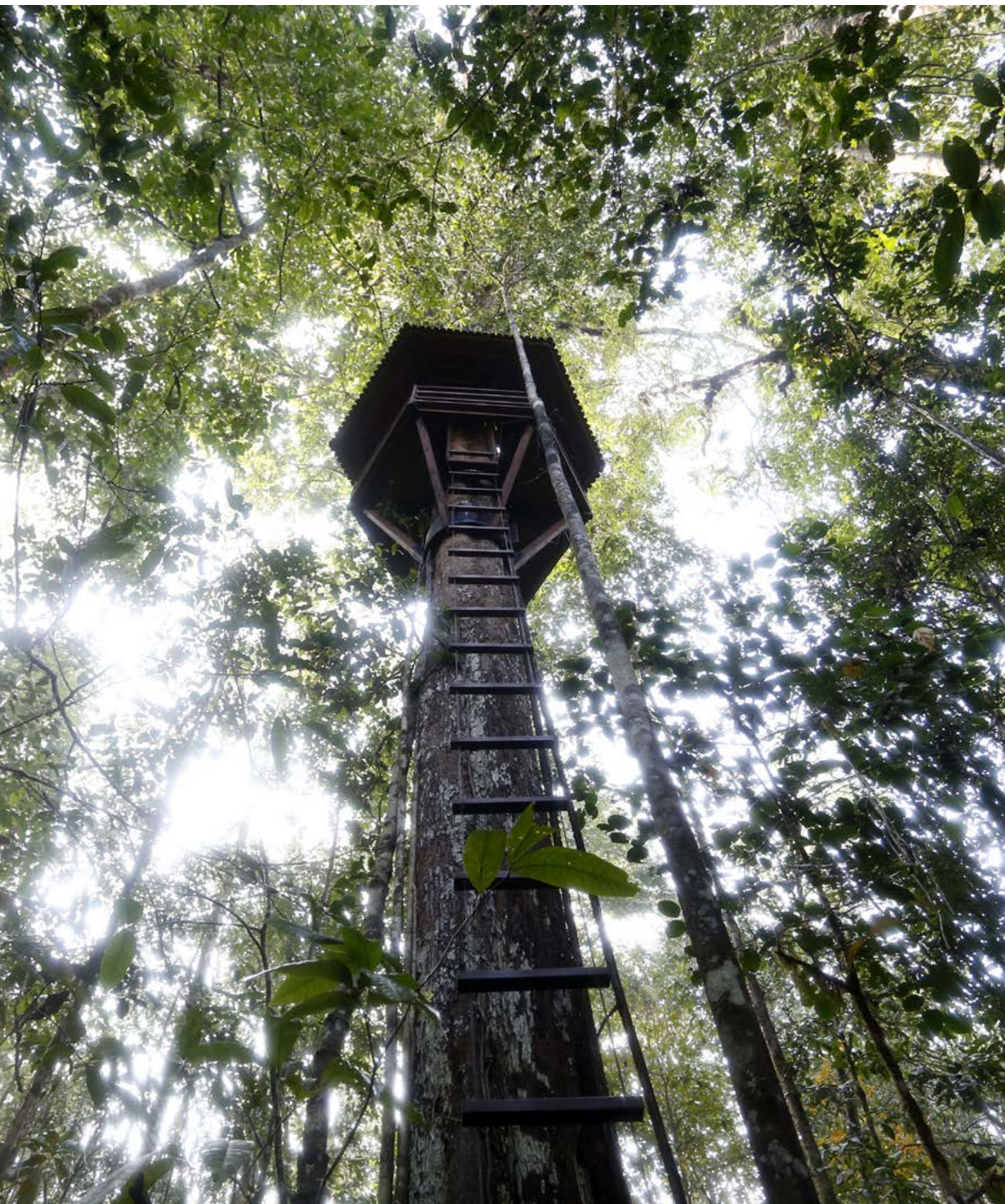
Tampak menjulang tinggi rumah pohon di Binagara yang dijadikan sarana untuk pengamatan burung ( birdwatching ). © Toto Santiko Budi
