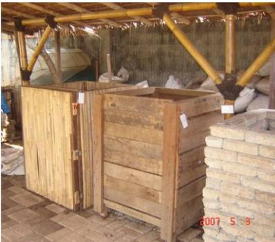
**Gambar 33:** Metoda ini menggunakan konstruksi sederhana pasangan bata yang dikombinasikan dengan bilik kayu sebagai pintu untuk ruang pengomposan. Cara ini digunakan di Kebun Karinda Lebak Bulus, Jakarta.
