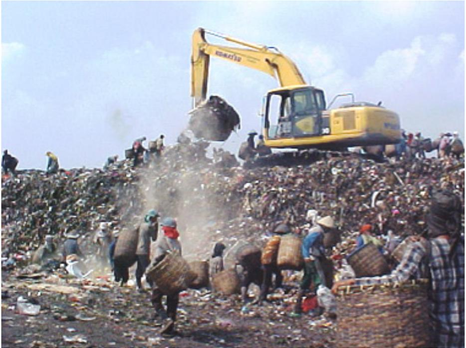
**Gambar 3: TPA di Indonesia umumnya masih menerapkan system pembuangan terbuka (*open dumping*)**
