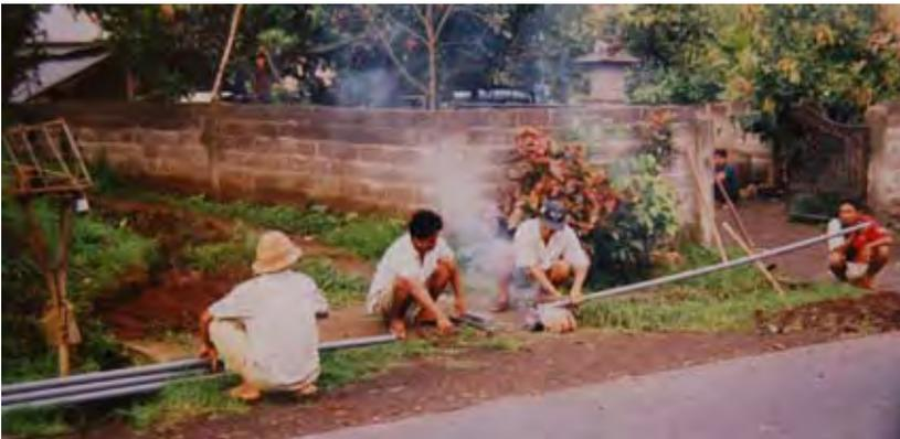
Beruntung sumber air berada di daerah yang lebih tinggi dari Desa Bengkala sehingga tidak perlu pompa untuk mengalirkan air, cukup memanfaatkan pergerakan gravitasi air. Beberapa warga yang memahami cara menyambung pipa pun turut membantu.
